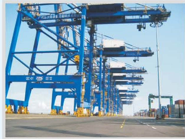
南沙海港集装箱码头中心变电站
