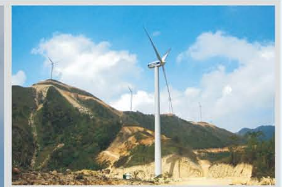
▼ 湖南郴州鲁荷金风电场项目
