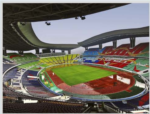
广州亚运会场馆项目
