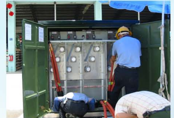
▼ 电缆分接箱安装
