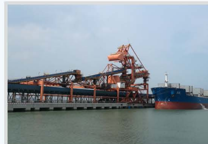
神华集团黄骅港岸电改造项目5台1600干变
